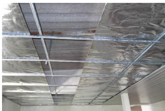
Figura 7 – Instalação Manta Interna.
