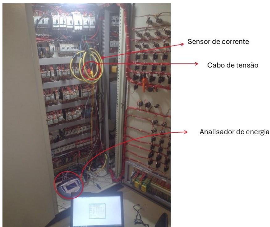
Figura 9 – Estrutura montada para a leitura em campo
