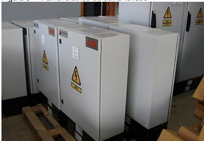
Figura 8 – Painél elétrico de baixa tensão
