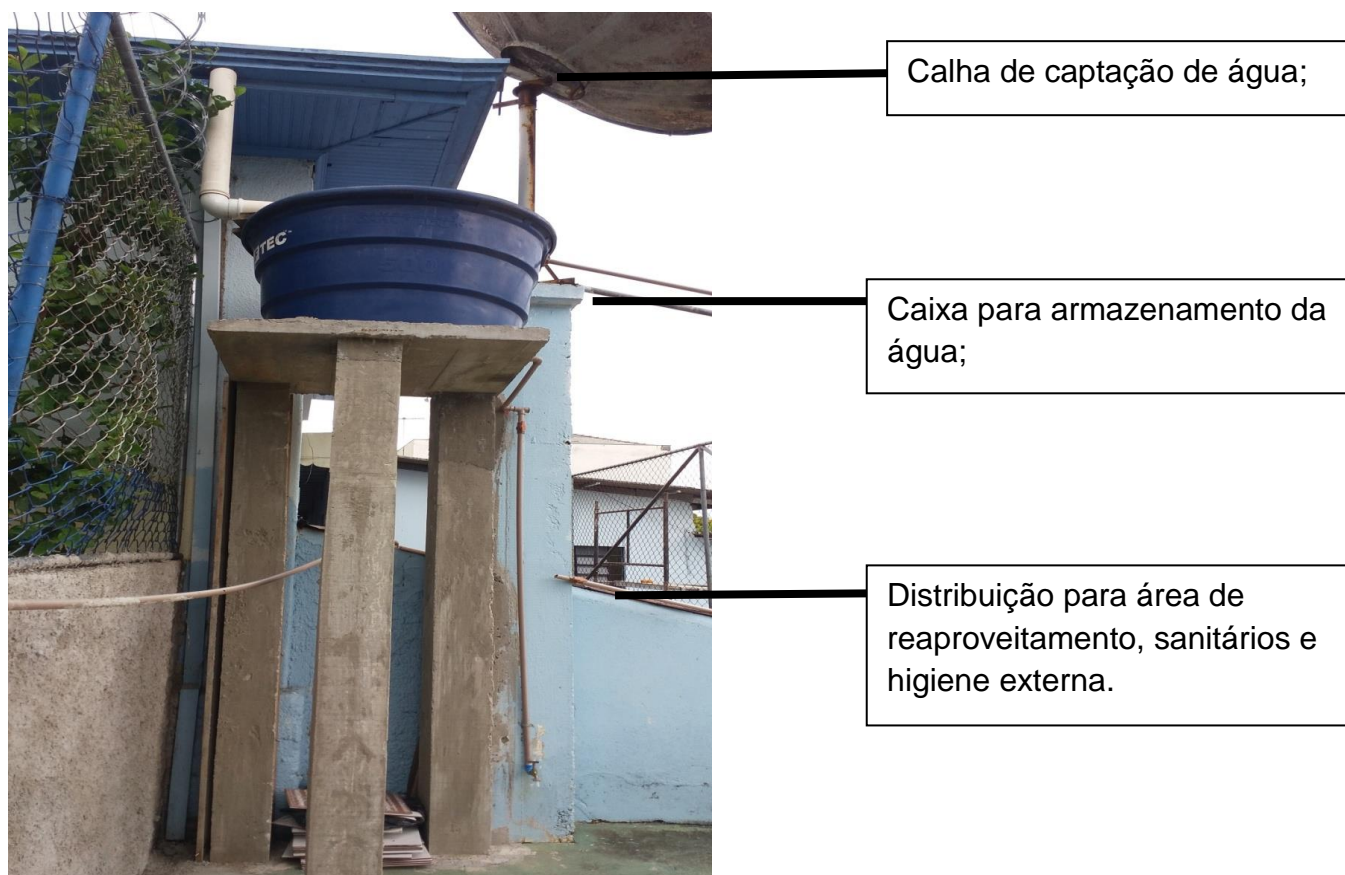
Figura 5 - Estrutura de armazenamento da água da chuva, para uso não potável.
